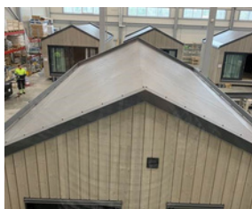
Förberett för sedumtak
